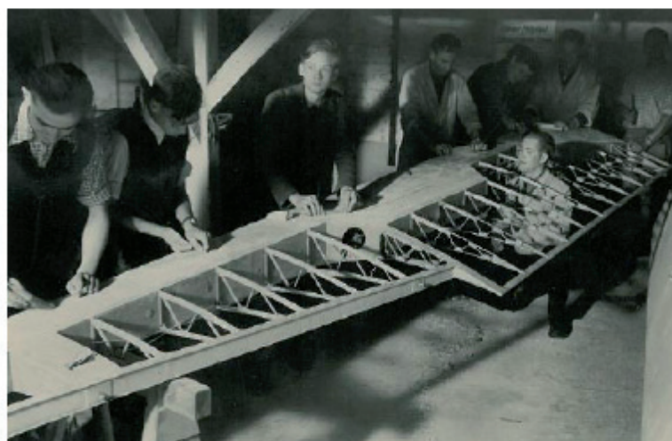
Bau eines Segelflugzeuges am Lambertiplatz
